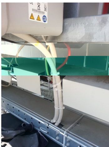
Connessione del cavo di stringa all'inverter
